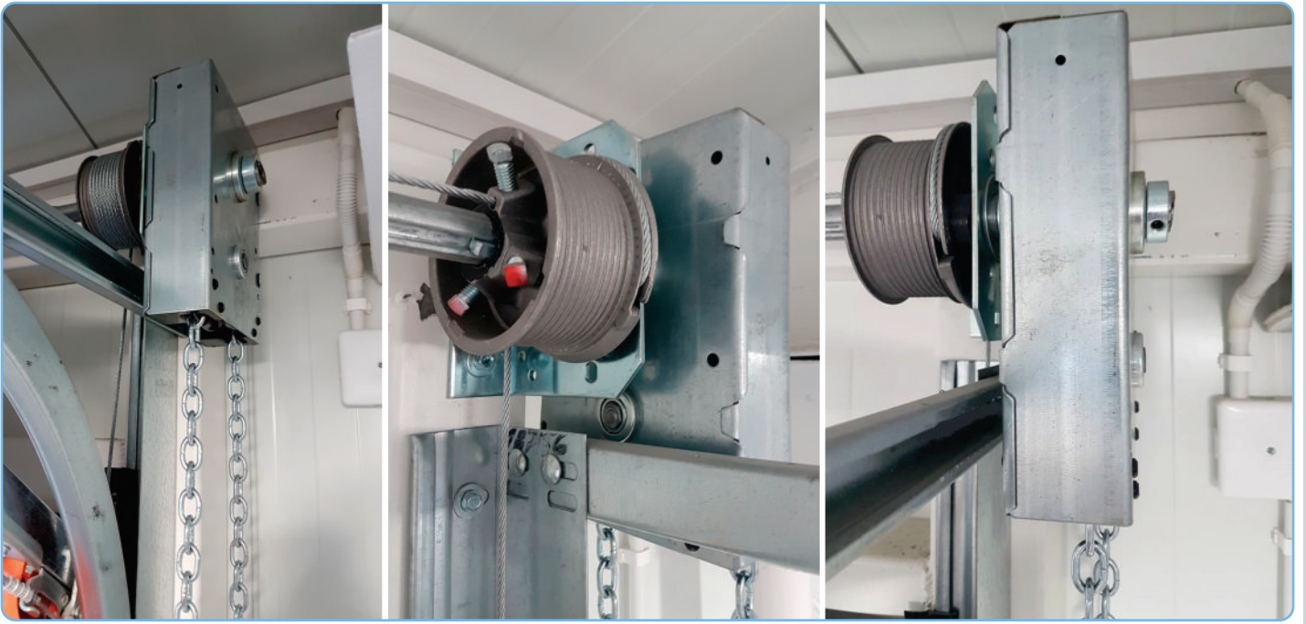
Kettenantrieb und Trommel
