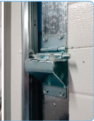
Seitenscharnier mit Rolle
