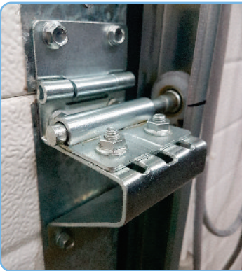
Seitenscharnier mit Rolle
