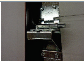
Verbindung des Winkelprofils mit der Führungsschiene durch Druck
