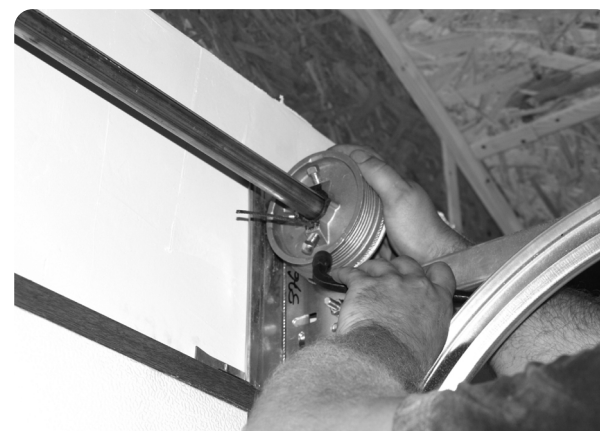
14. Regulacja lin nośnych justowanie bramy
