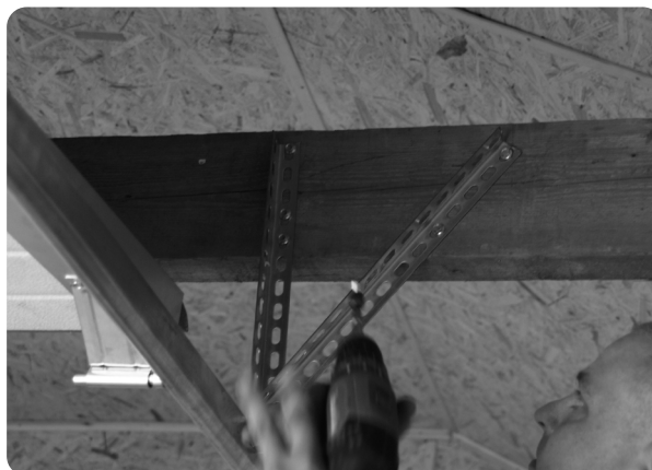
10. Kątownik perforowany lub podwieszenie L do montażu prowadnic poziomych
