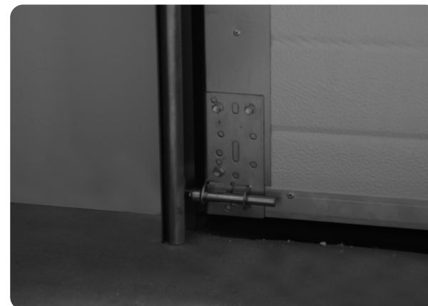
11. Montaż 1 sekcji płyta
