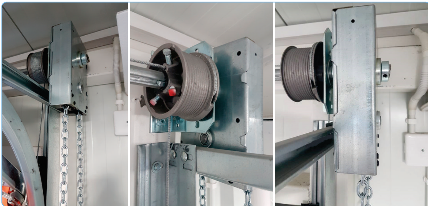
PRZEKŁADNIA ŁAŃCUCHOWA I BĘBEN
