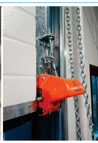
ZABEZPIECZENIE NA PĘKNIĘCIE LINEK z osłoną i mikrowyłącznikami zabezpieczającymi przed opadnięciem płata
