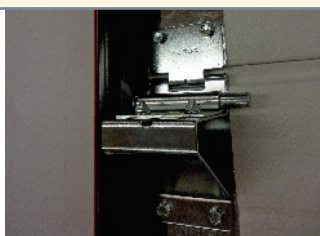
Połączenie prowadnicy z ościeżnicą poprzez przeciskanie
